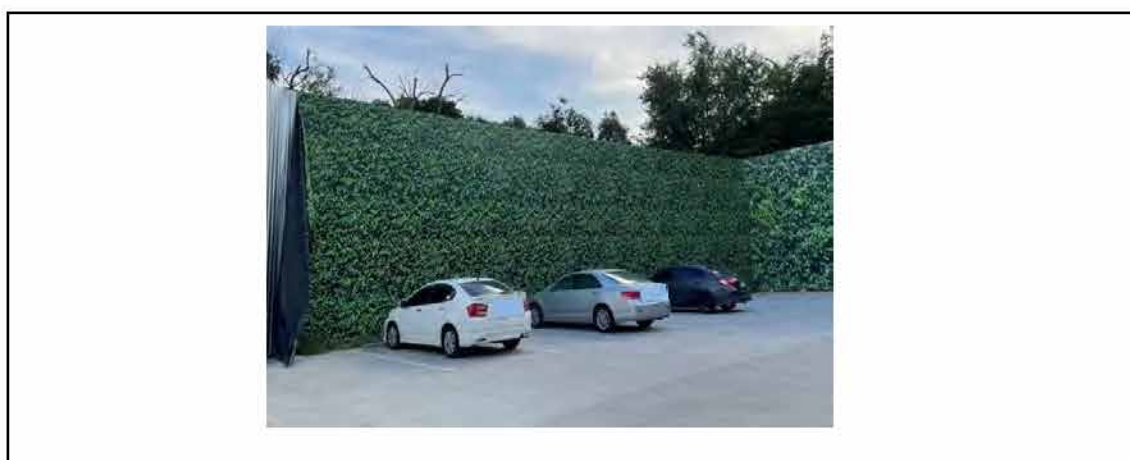
รูปที่ 2.12.1-2 ตัวอย่างการติดตั้งไวโนลบนรั้วชั่วคราว (ระยะก่อสร้าง) เพื่อลดผลกระทบด้านทัศนียภาพ
